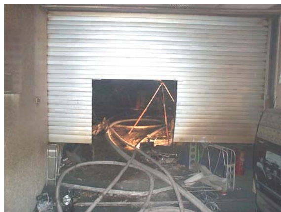
Abb. 5: Zugangstor (Rolltor) zum Bowling-Center [1]
