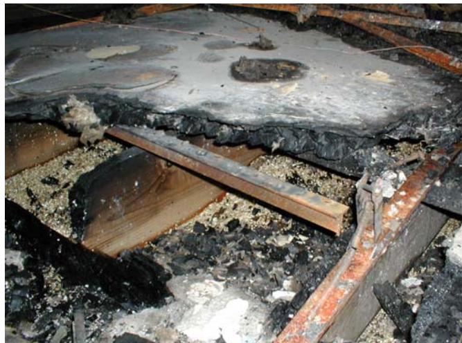
Abb. 7: Bodenaufbau im Bereich der Bowlingbahnen [1]
