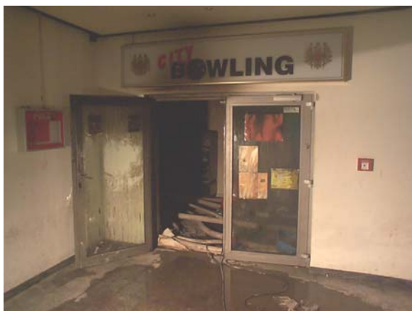
Abb. 4: Haupteingang (Vorraum) vom Treppenraum aus gesehen [1]
