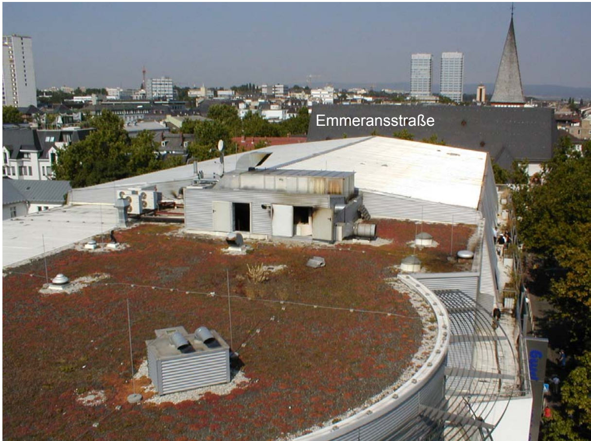
Abb. 3: Dachansicht mit Lüftungszentrale. Unter dem halbrunden begrüneten Bereich befindet sich das nicht vom Brand betroffene Restaurant. Der gesamte übrige Bereich gehört zum Bowling-Center. [1]
