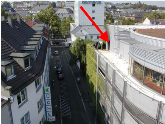
Abb. 8: Notausgang und Nachbarbebauung „Gymnasiumstrasse“ [1]
